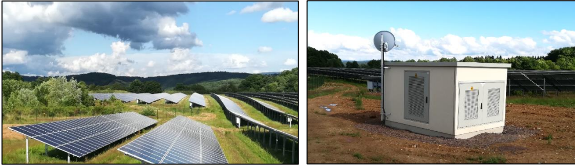
Abb. 3: Beispiel einer Freiflächenanlage (links) und einer Trafostation (rechts) (Foto: BGHplan Juni 2017).
