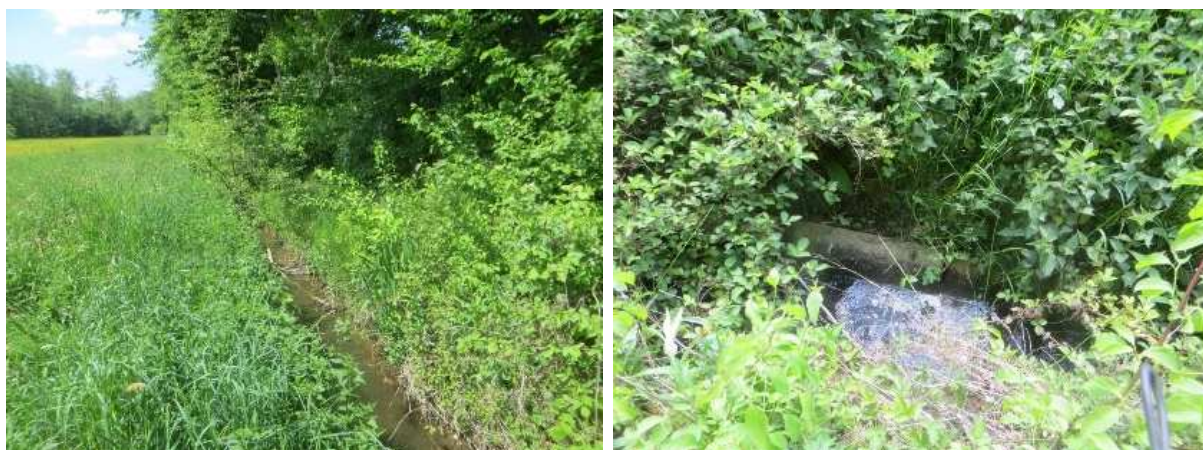
Abb. 4: begradigter bzw. angelegter Bachabschnitt des Östelbaches südlich der Planungsfläche ohne Krautsaum (links); Sicherung durch Betonhalbschale im Bereich der landwirtschaftlichen Überfahrt (rechts)
