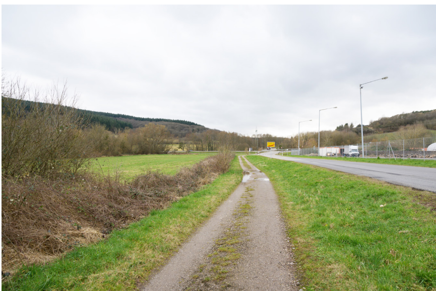
Blick Richtung Osten entlang der nördlichen Geltungsbereichsgrenze mit bestehendem Feldwirtschaftsweg und der Trierer Straße (L 53) im Bild
